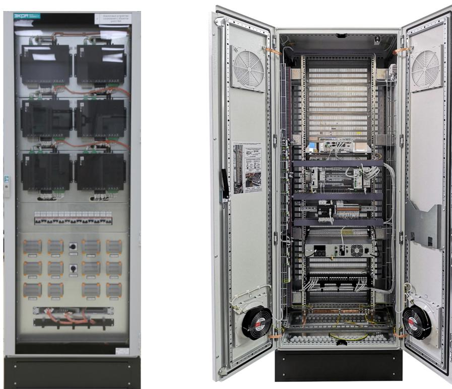
Рисунок 2 - Пример внешнего вида шкафа ШНЭ 9501(1140А)
